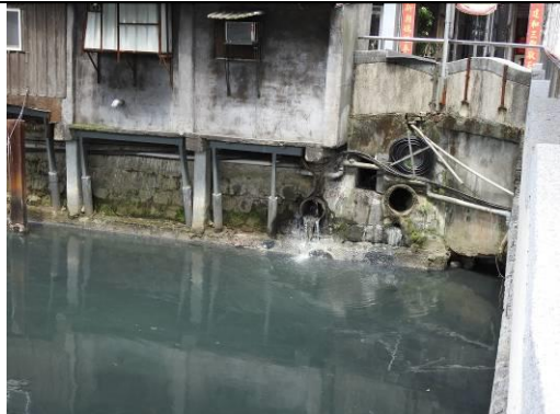
周邊有許多民生廢水排入西定河
