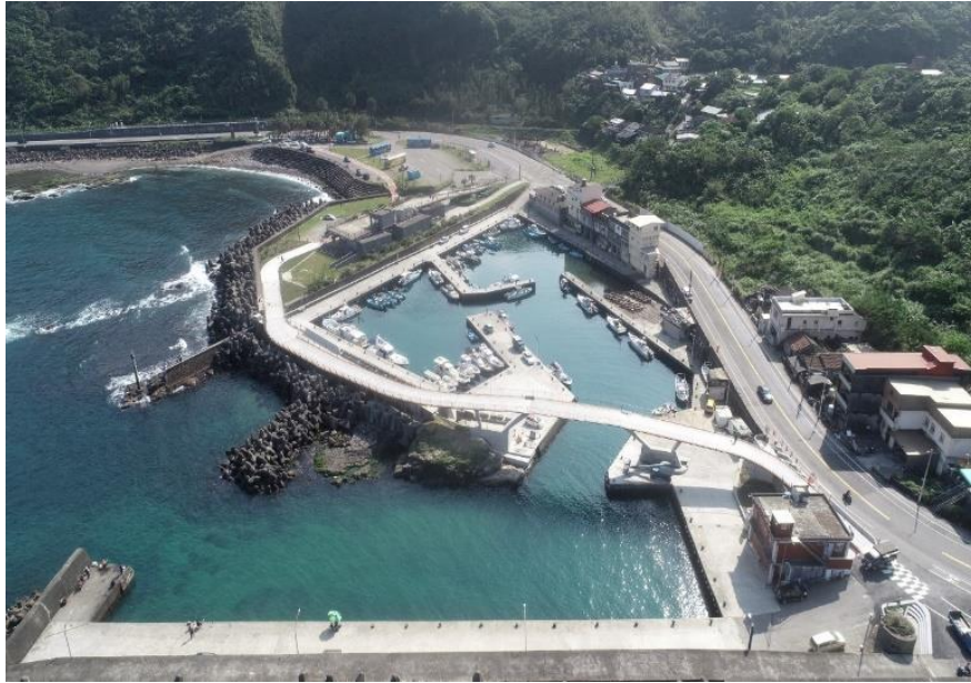
圖 4-3 第一階段工程望海巷景觀跨橋工程
