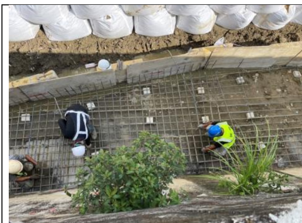
太空包圍堰堵水 設置日期 110/11/16
