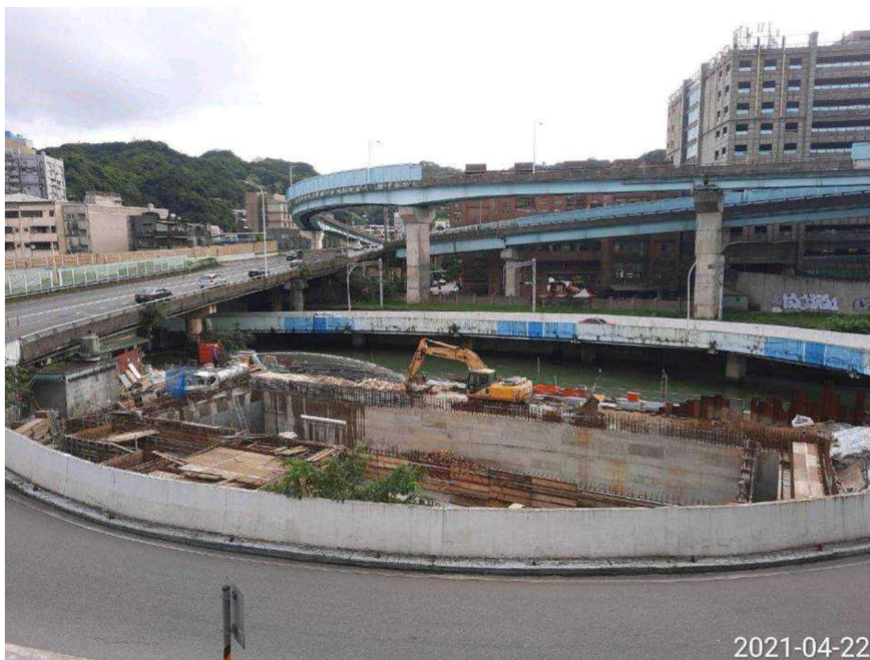
圖 4-35 旭川河現地處理設施施工現況
