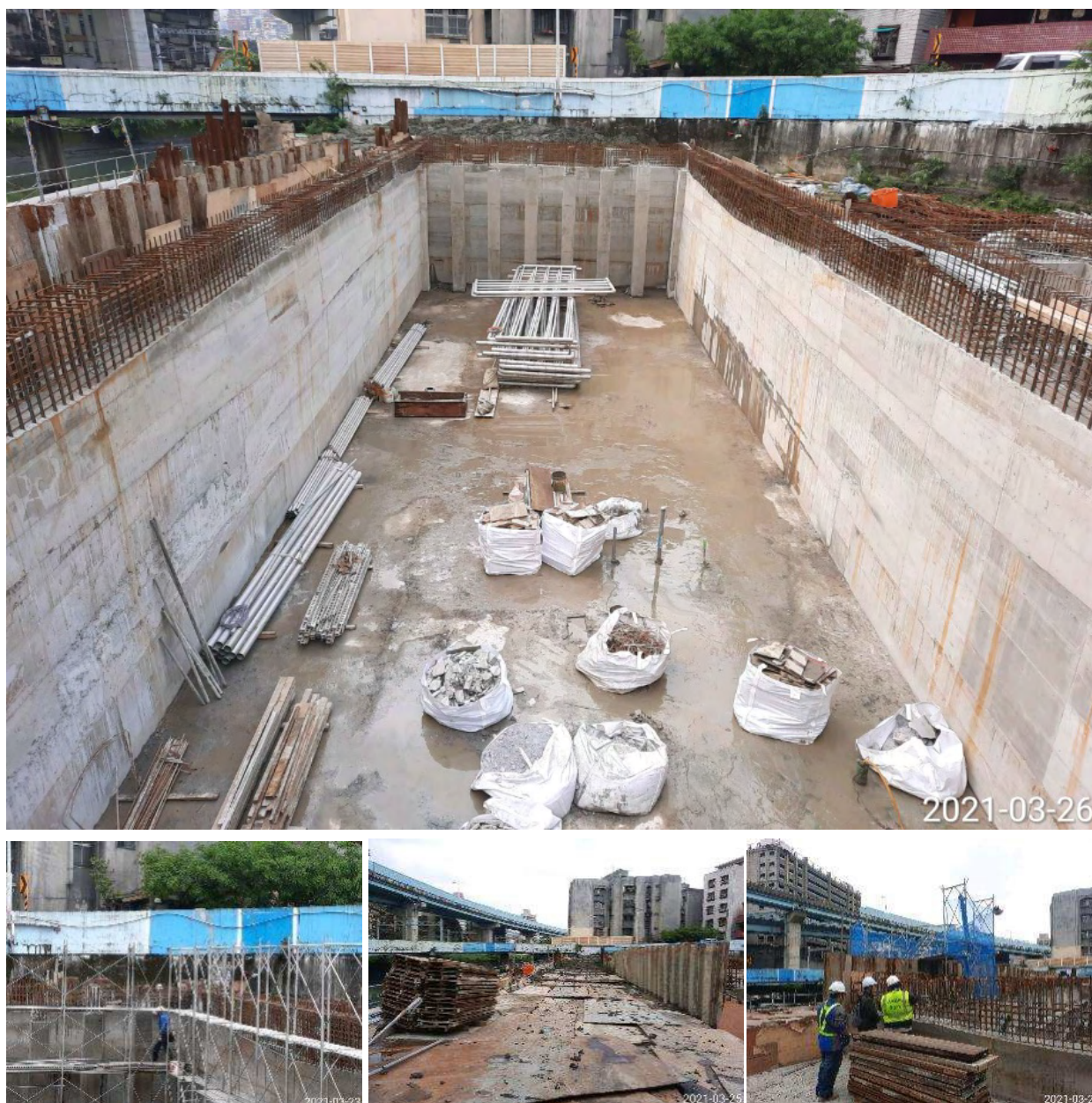
圖 4-36 旭川河現地處理設施施工現況
