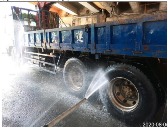
說明：卡車駛離工地前清洗輪胎。
