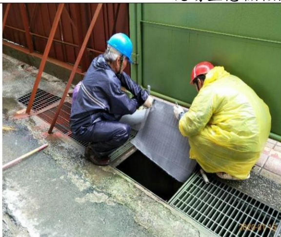
說明:工區排水設施加裝濾網
