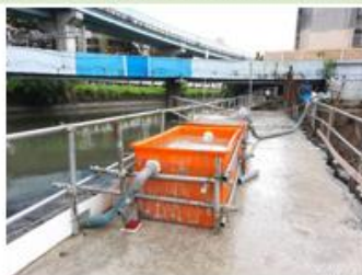
工區排水汙物清理 沉澱池
