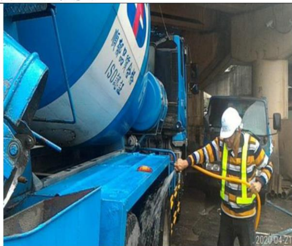
說明:預拌車駛離工地前清洗輪胎淤泥
