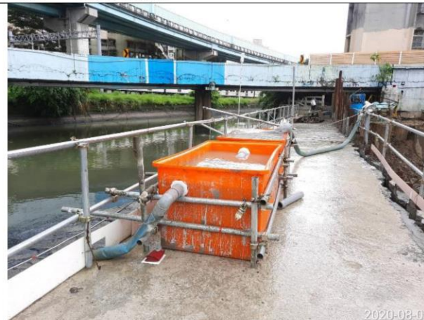
說明：工區排水汙物清理沈澱池。
