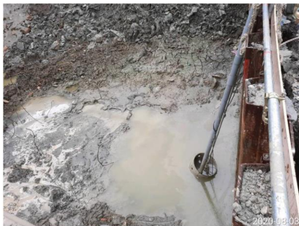
說明：集水區抽水作業。
