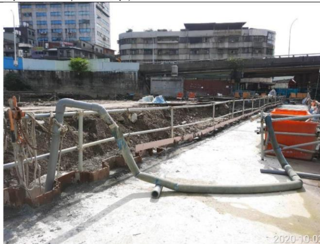
說明：抽水設備安設。
