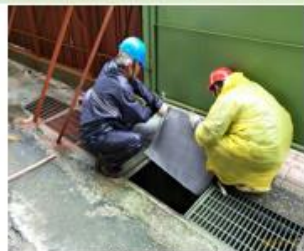
工區排水設施加裝濾網
