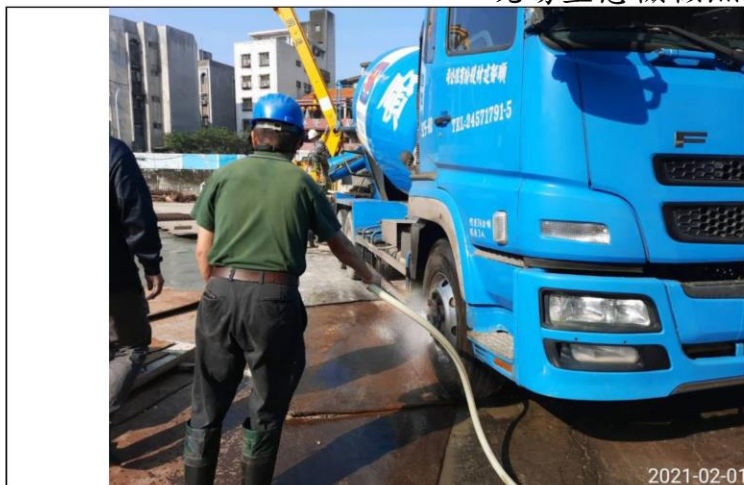
說明：卡車駛離工地前清洗輪胎。
