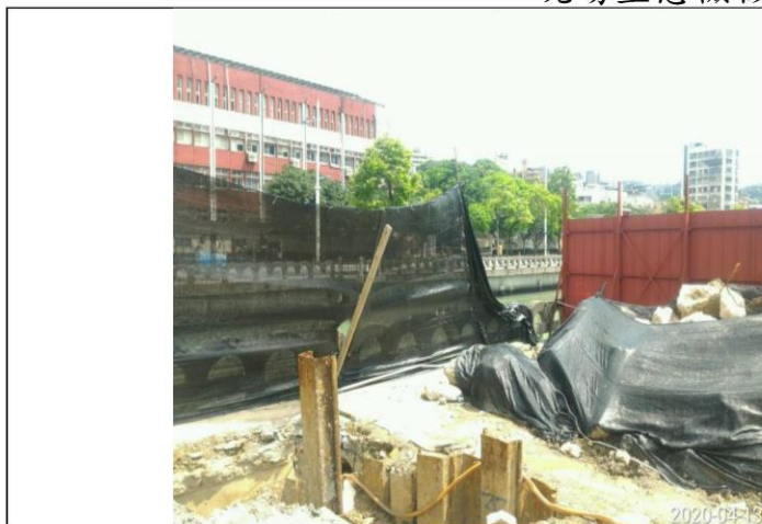
說明：施工圍籬強風吹損
