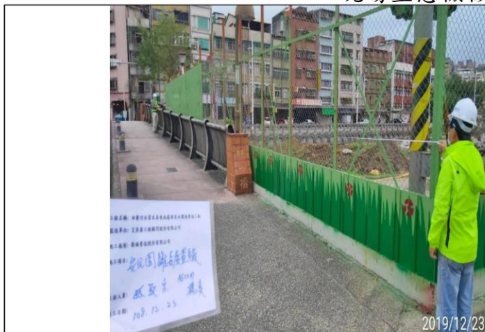
說明：施工圍籬查驗
