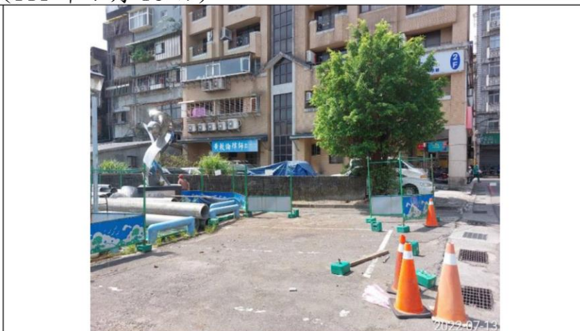
說明：東明大排工地現況，保全既有行道路。
