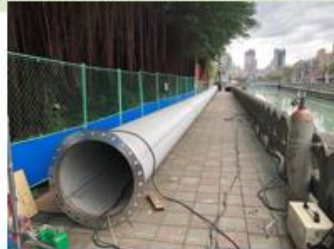
移動式施工圍籬 保護行道樹
