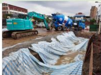
沉澱池開挖製作
