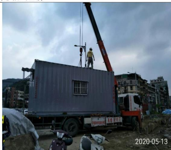
說明：工地休息區，貨櫃屋吊放已避免傷害行道樹
