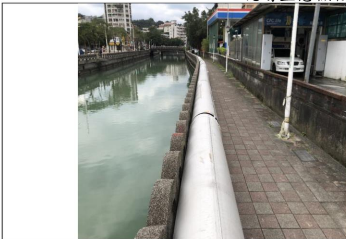
說明：左岸配管靠臨水測暫置，避免影響行道樹。
