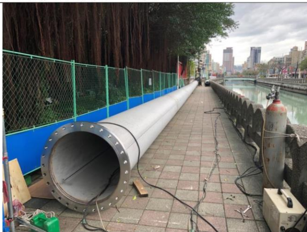
說明：左岸配管近行道樹渠段，增設施工圍籬區隔保護行道樹。
