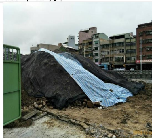
說明：土方堆置覆蓋
