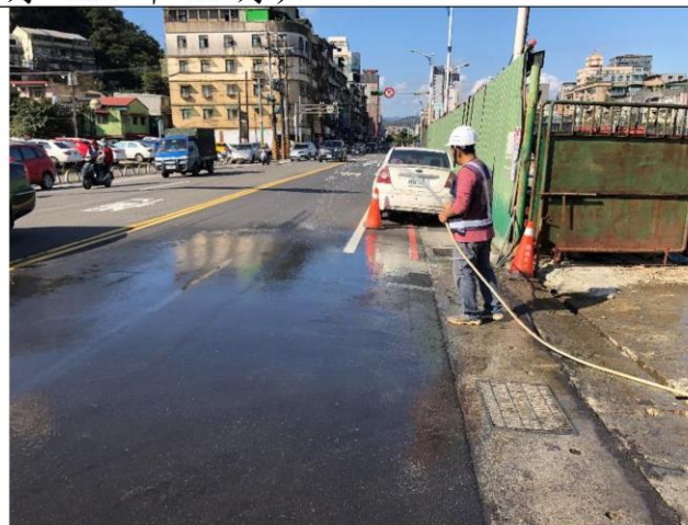
說明：工區內及外側道路灑水降低揚塵
