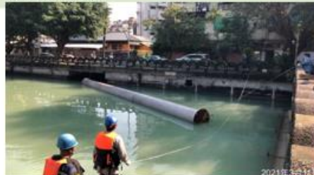
配管自橋面吊掛至河面，採 漂浮及拉引避免影響行道樹
