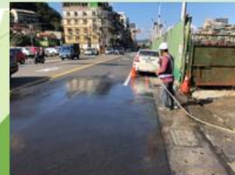
工區內及外側道路 灑水降低揚塵
