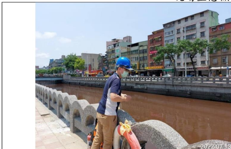
說明：田寮河受感潮影響流速慢且底泥淤積，受上游污染源影響水質不佳。
