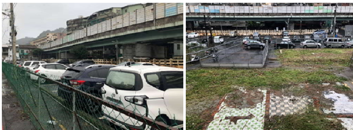
圖 4-1 台鐵舊宿舍工址現況照片
