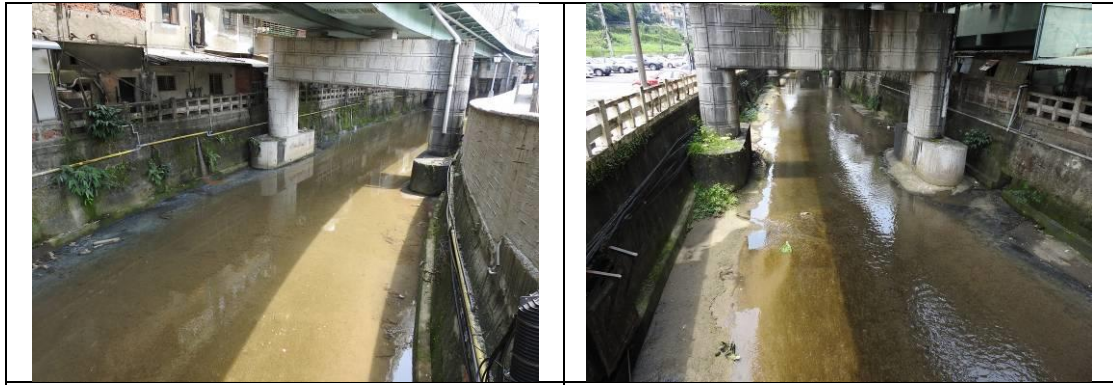
西定河環境現況
